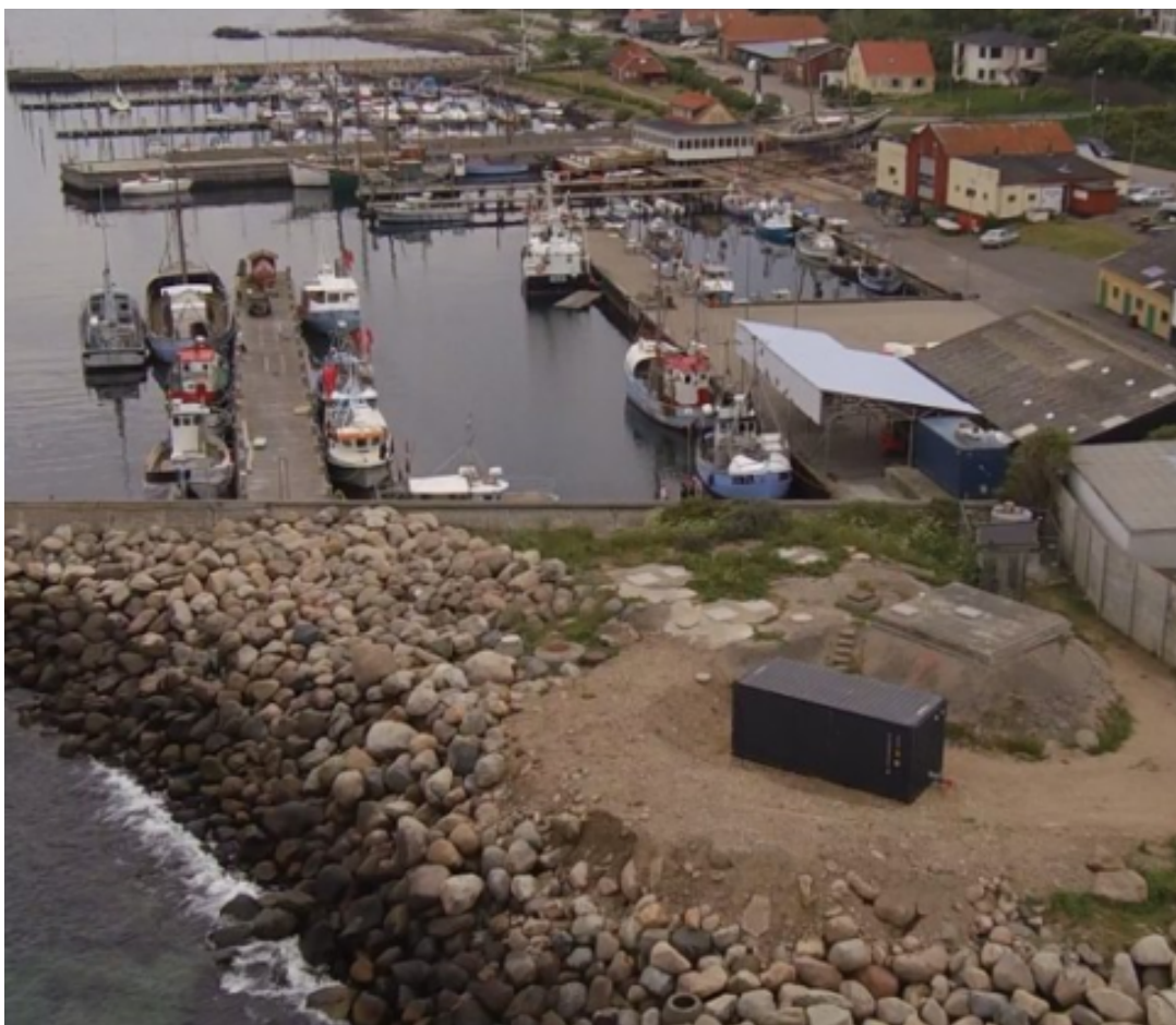
Billede 1: Luftfoto af det gamle renseanlæg.
