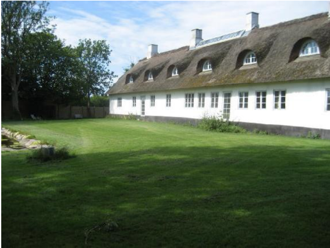
Fig. 5. Græsplænen nord- syd hvor rørføring er mellem sø og hovedbygning. Grundstenen i Grundtvigs forældres tidligere præstegård er jo lagt i 1520'erne, og fundamentet er kampesten, hvilket naturligt passer til søens kampestenssætning. Da jorden på ejendommen i rørføringsdybde er plastisk ler, så er det ikke godt for den 34 meter lange hovedbygning med alt for megen fremtidig gravearbejde på matriklen.
