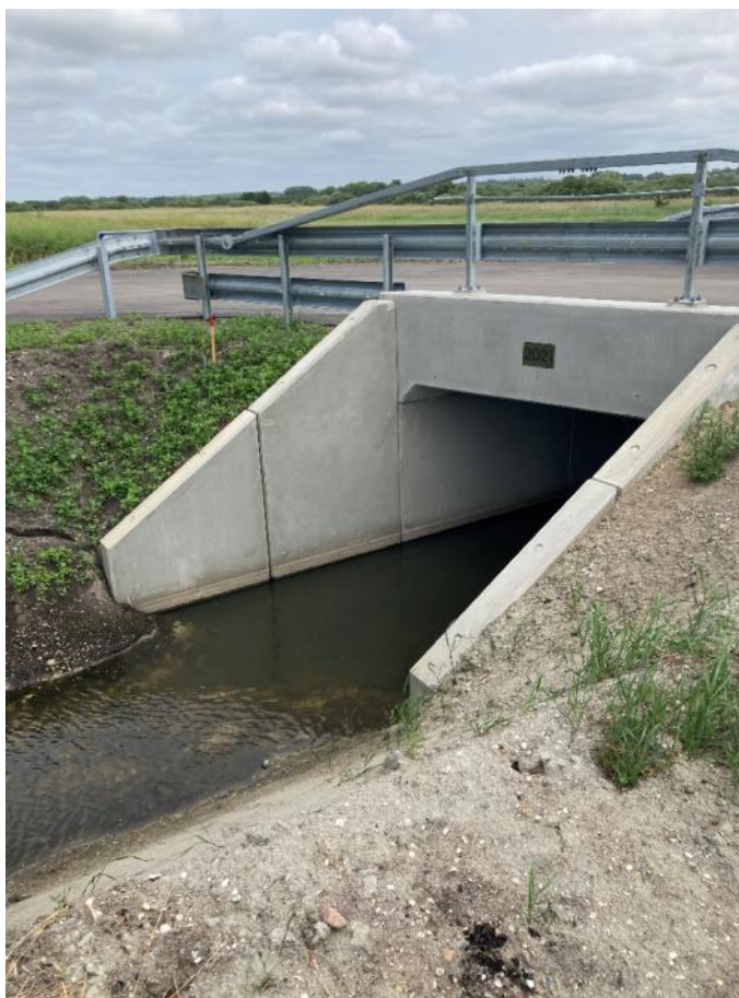
Figur 4: Ny overkørsel i Fuglebæks Å ved Trundholm Mosevej.
