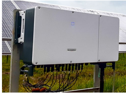
Figur 1-4 Eksempel på inverter, som omdanner den producerede jævnstrøm til 230 V vekselstrøm. Invertere placeres under eller i forlængelse af solcellemodulerne.
