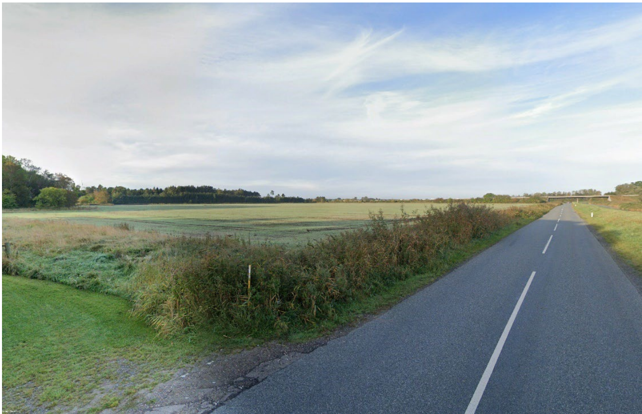
Figur 8-35 Punkt 8 – Eksisterende forhold.
